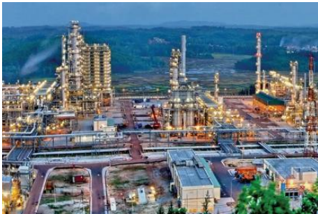
Nhà máy Lọc dầu Oil Refinery
